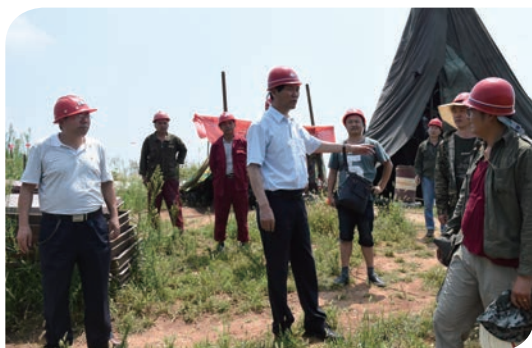
集团党委书记、董事长赵廷周到项目现场安全检查
