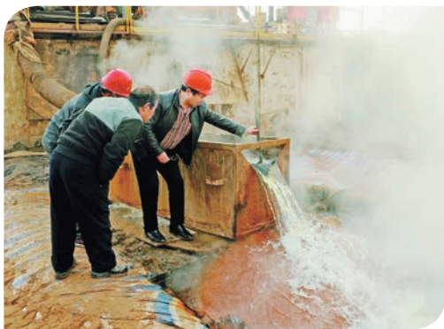
韩城市地热探采结合井工程
